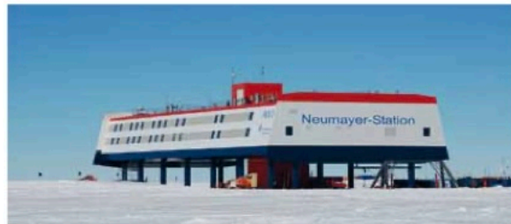
Polar-Forschungsstation in der Antarktis © Wurst Stahlbau GmbH
